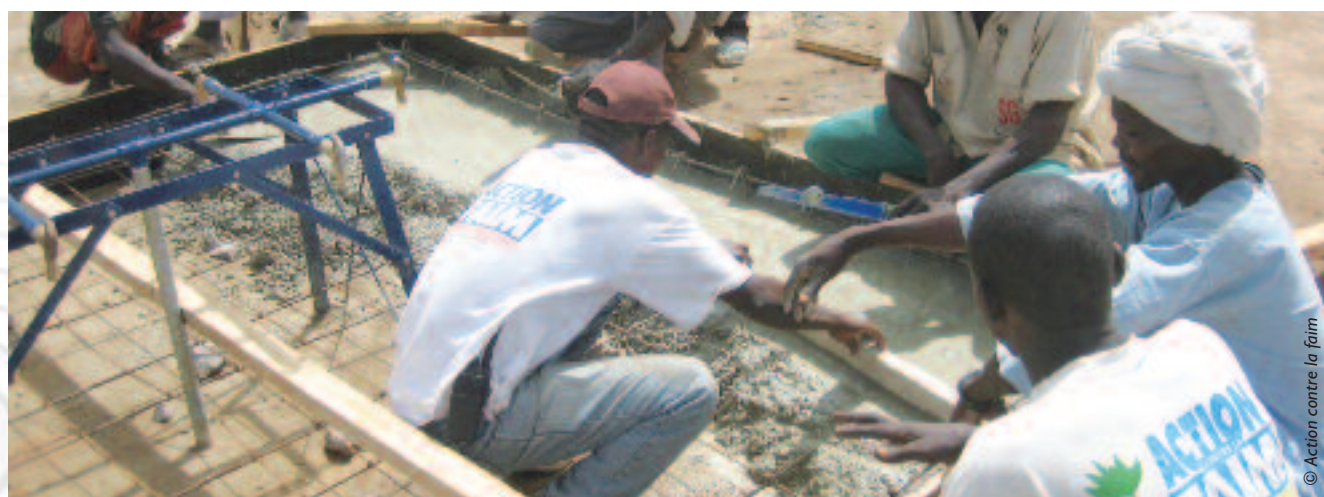
Construction d'un point d'eau, Tchad.
