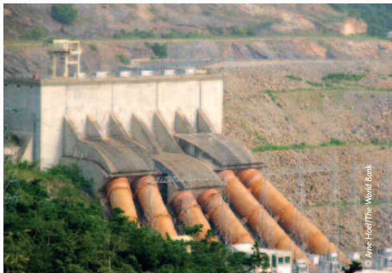
Centrale hydro-électrique, Ghana.
